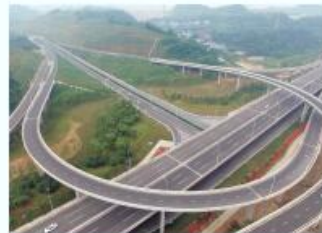
宜昌市江城大道(南嘴长江大桥—夷桥路)市政工程及江南二路1#桥桥梁工程 施工单位：中文第一公路工程有限公司 监理单位：葛洲坝集团项目管理有限公司
