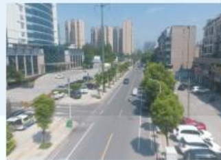
金龙路（武德路—北京路）道路改造工程 施工单位：荆州市路远市政工程有限公司 监理单位：珠海巨业建设监理有限公司
