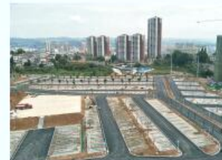
宜昌三峡旅游咨询服务中心(夜明珠停车场)项目土石方、生态停车场及市政配套设施工程 施工单位：湖北沛雨建设有限公司 监理单位：中冶南方武汉威仕工程咨询管理有限公司
