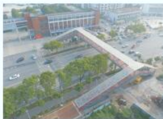
荆门北高速出入口综合整治工程 施工单位：武汉市市政建设集团有限公司 监理单位：武汉华社工程建设科技有限公司
