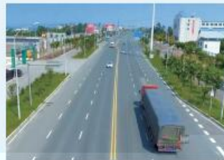
荆门南高速出入口综合整治工程 施工单位：广州建筑股份有限公司 监理单位：武汉市政工程设计研究院有限责任公司 王永超 摄
