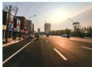
潜江市“城市双修”建设项目—江汉路人行道改造工程 施工单位：天恩建设集团有限公司 监理单位：湖北潜江工程建设项目管理有限公司 彭雨摄
