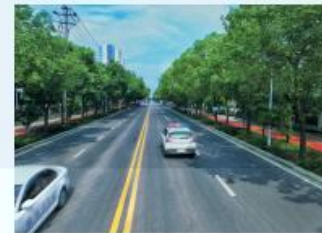
枝江市七星大道刷黑改造工程 施工单位：湖北国中建设有限公司 监理单位：杭州天恒投资建设管理有限公司
