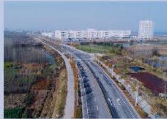
武穴市东城区16号路(20#路至T1#路)建设项目(银奖) 施工单位: 湖北振天建筑工程有限公司 监理单位: 湖北东晟工程监理有限责任公司 何建华 摄
