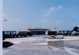
枝江市火车站南广场二、三期工程 施工单位: 湖北恒诚建设有限公司 监理单位: 宜昌智强建设工程技术咨询有限公司 宜昌宏业工程项目管理有限公司 杨涛霖 摄
