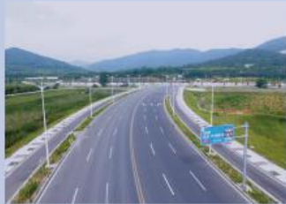
襄阳市滨江路东延段新建工程c标(金奖) 施工单位: 襄阳路桥市政(集团)工程处 监理单位: 武汉江南工程建设监理有限公司 乐精明 摄
