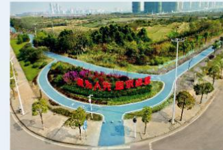
未来科技城及周边片绿道工程 施工单位：武汉市市政建设集团有限公司 参建单位：武汉市市政道路排水工程有限公司 监理单位：宜昌宏业工程项目管理有限公司 工 艳 摄
