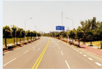
武汉新区墨水湖南路道路排工程 施工单位：武汉市汉阳市政建设集团公司 武汉致远市政建设工程有限公司 武汉博宏建设有限公司 监理单位：武汉市政工程设计研究院有限公司 第一清 摄
