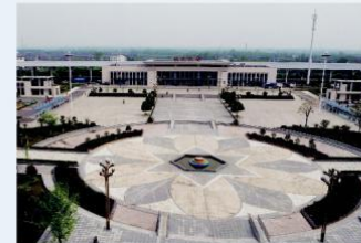
荆江市火车站前广场二、三期工程 施工单位：湖北恒诚建设有限公司 监理单位：宜昌毅强建设工程技术有限公司 宜昌宏业工程项目管理有限公司 杨芳媛 摄
