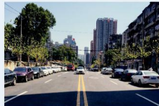
武路六巷（武珞路——中南一路）道路排水工程 施工单位：武汉顺跃市政工程有限公司 监理单位：武汉市政工程设计研究院有限责任公司 郭江波 摄
