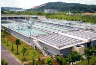
金口水厂一期—净水厂工程 施工单位：武汉市城建工程有限公司 中太建设集团股份有限公司 武汉市水务建设工程有限公司 武汉市科发园林绿化有限责任公司 监理单位：武汉扬子江工程监理有限责任公司 黄诗文 摄
