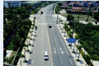
月堤路（沿江大道——荆沙大道） 道路改造工程—标段（沿江大道——幸福一路） 施工单位：荆州市路远市政工程有限公司 监理单位：湖北楚元工程建设咨询有限公司 刘建华 摄
