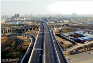
武汉市长丰大道（二环线——三环线）桥梁工程 施工单位：中国一冶集团有限公司 参建单位：中铁七局集团有限公司 监理单位：武汉宏宇建设工程咨询有限公司 武汉市政工程设计研究院有限责任公司 张天和 王天雄 摄
