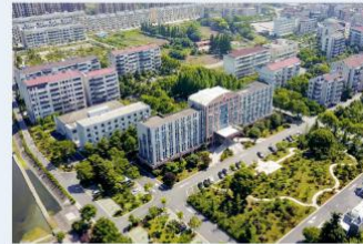
江陵县政府机关庭院道路、排水、景观改造工程 监理单位：湖北德馨建设工程咨询有限公司 施工单位：荆州市东成市政工程有限公司 胡丹 摄
